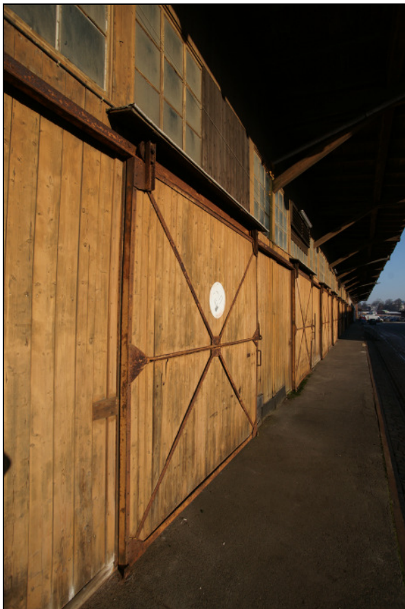
Der Schuppen B entlang der inneren Erschließungsachse mit den historischen Gleissträngen von 1892 ff und der alten Pflasterung. Originaler Erhaltungszustand, lediglich die linke Halle ist aus Einbruchssicherheits- und Feuerschutzgründen mit Wellblech benagelt — eine schnell reversible Maßnahme, die keine Auswirkungen auf den Denkmalwert besitzen kann. Von gleicher Qualität ist der Schuppen D, dessen Erhaltungszustand durch die ständige Pflege der derzeitigen Pächter gänzlich ohne Beanstandung ist.
